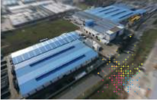
Georg Fischer Hakan Plastik Çerkezköy Üretim Tesisleri
